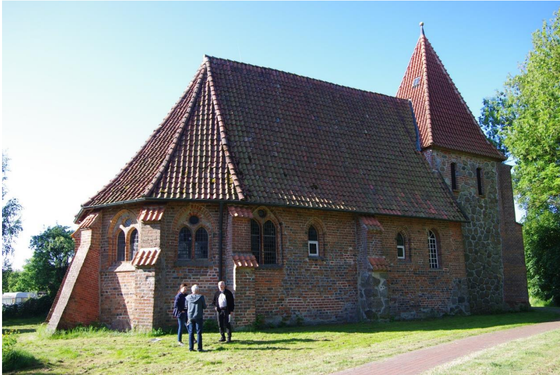
Auch die Dacheindeckung der Kapelle St. Marien in Oetzen soll über die Dorfentwicklung gefördert werden.
